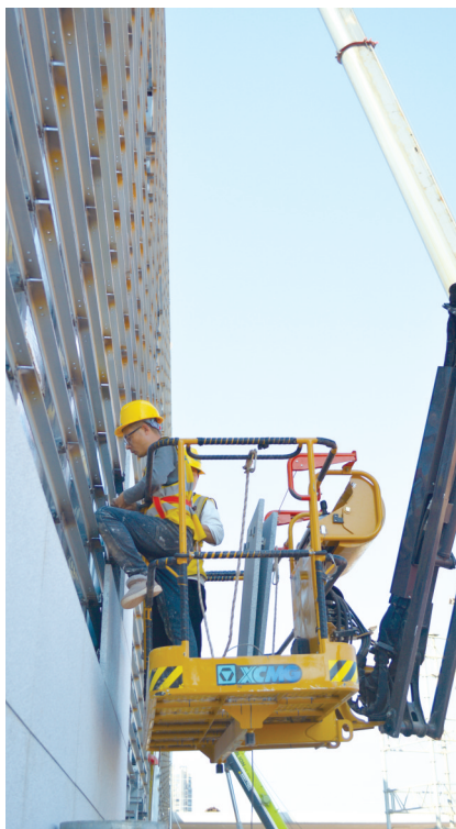
■五华站施工现场 全媒体记者梁鸿杰/摄
