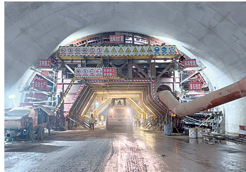
■汕梅高速改扩建项目现场,工人在准备二次衬砌施工。
