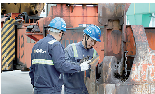
■技术部抢修室进行保养修理。
