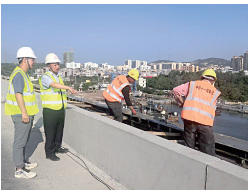
■谭庆令(左二)检查施工质量。
