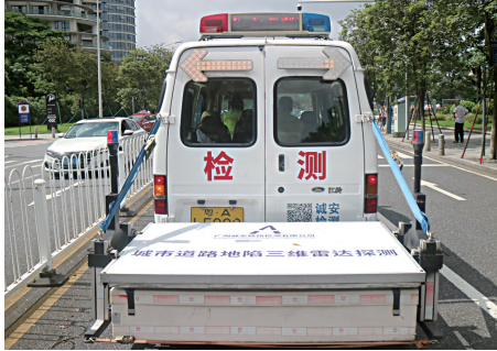
■城市道路地陷三维雷达探测系统在检测道路病害。全媒体记者彭新启/摄
