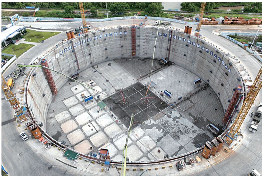
■狮子洋大桥西锚碇按九宫格浇筑混凝土。
