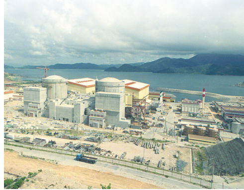
▲1991年,建设中的大亚湾核电站。
