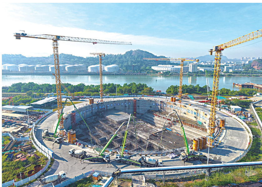
■狮子洋大桥西锚碇正在填芯施工。
