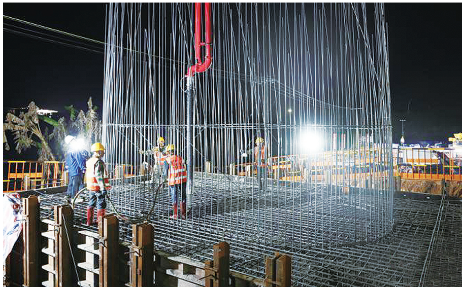
▶首个承台混凝土浇筑现场。 龙敏/摄
