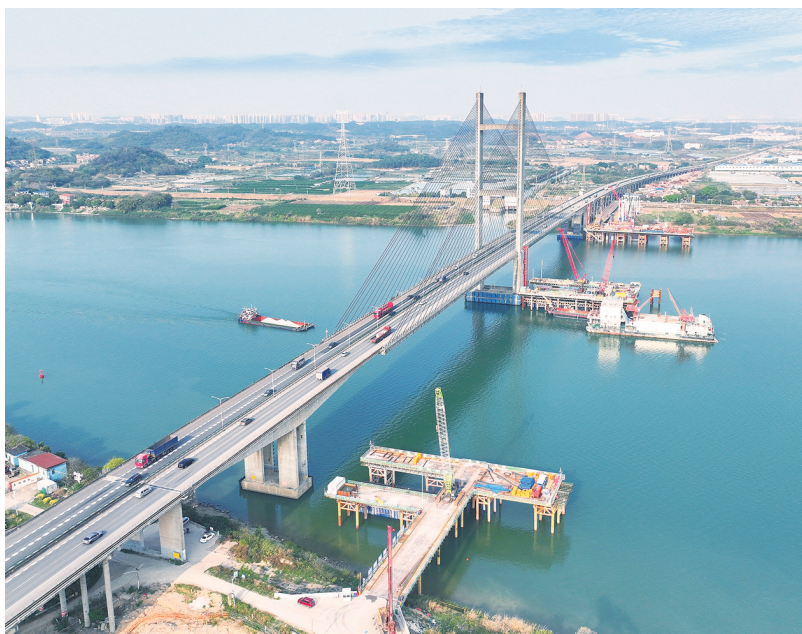
■金马大桥首个主墩承台浇筑现场。
