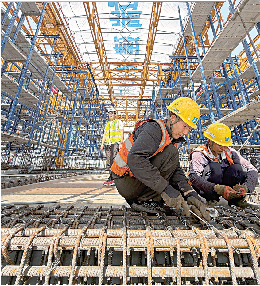
■广州环球贸易广场项目施工现场。
