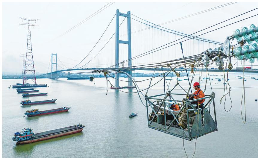
■狮子洋大跨越段架线施工中,作业人员正在空中吊笼压接导线。
