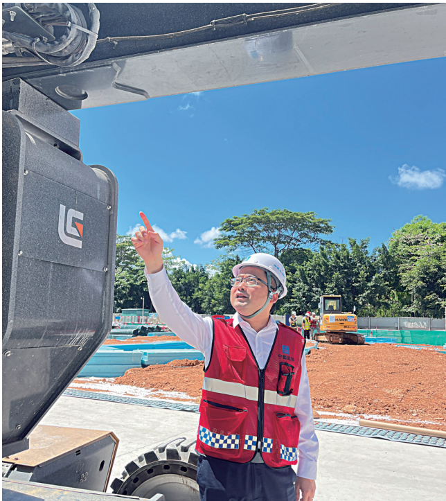
■杨冬进行日常现场巡查。 单位供图
