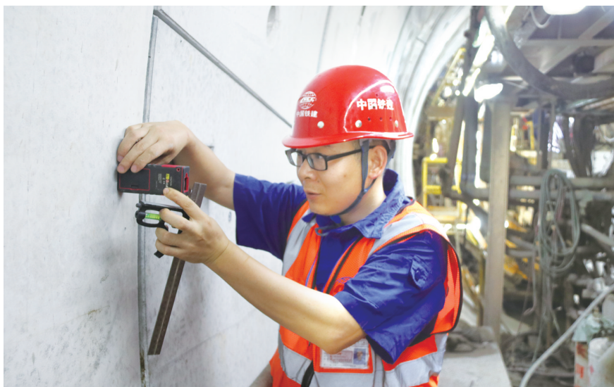
■刘治文在深圳地铁16号线共建管廊项目施工现场检测。
