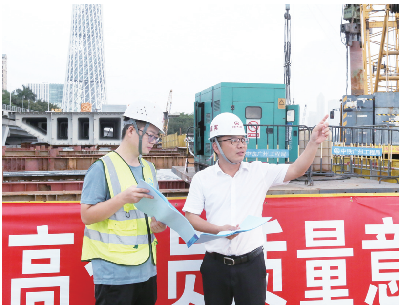
■曹科(右)在广州市黄埔涌步行桥现场指导施工。
