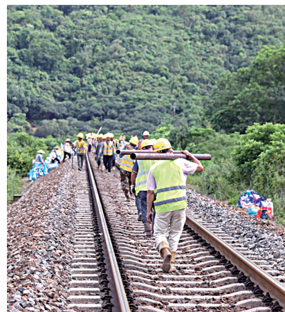
广茂铁路抢修现场。
