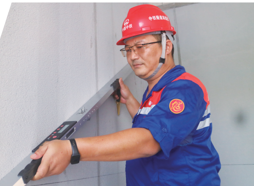
郭源使用工具检测墙壁的平直度。全媒体记者彭新启/摄
