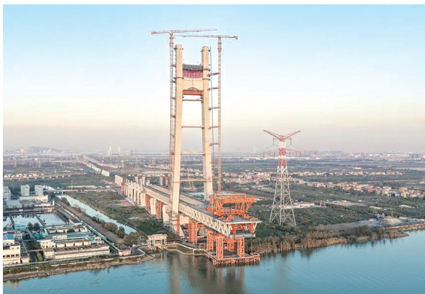
■深江铁路洪奇沥水道公铁大桥50号墩主塔顺利封顶。
