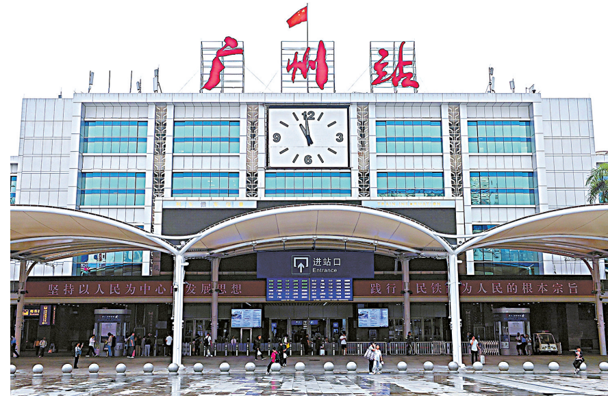
■广州站楼顶“广州站”标识完成专项修缮。
